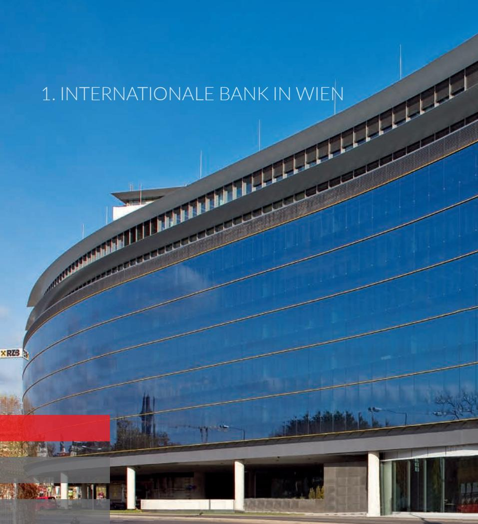
**1** Für eine internationale Bank in Wien entstand ein Bürohaus mit elegant geschwungener Glasfassade. Bei der großzügigen Fenster- und Fassadenkonstruktion wurde unter anderem UNIGLAS® | PHON Lärmschutzglas mit Multifunktions-Eigenschaften eingesetzt. Das Marken-Isolierglas schirmt die Büros gegen den Straßenlärm von der mehrspurig vorbeiführenden Straße ab. Gleichzeitig dient das Isolierglas als Schutz gegen die intensiv einstrahlende Nachmittagssonne.
